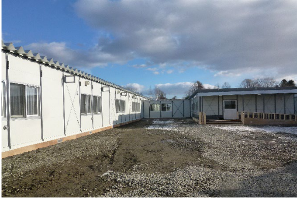
厚真町 福祉仮設住宅（外観）
