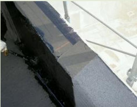
図 8.13 パラペット立上がり下部のシート端部の施工例
