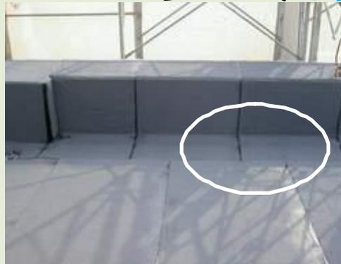
写真 8.11 シートの接合位置の施工例
