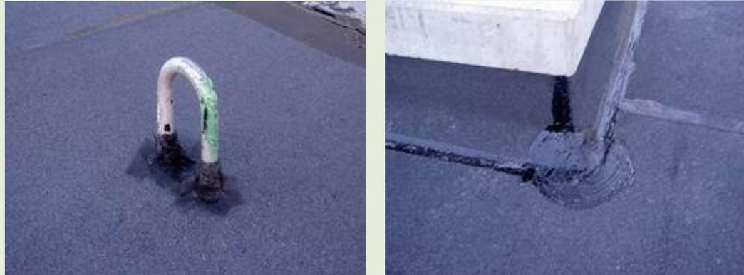
写真 8.17 フック足元、出入隅の防水補強の例
