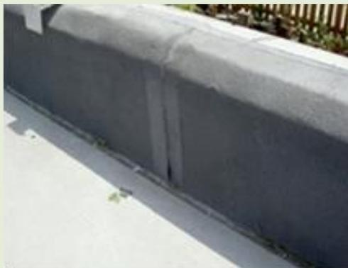
図 8.14 パラペット先端部の施工例
