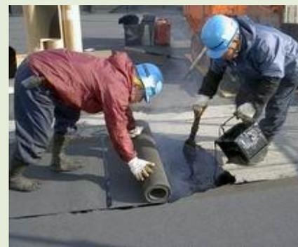
写真 8.16 アスファルト溶融と流張り施工例
