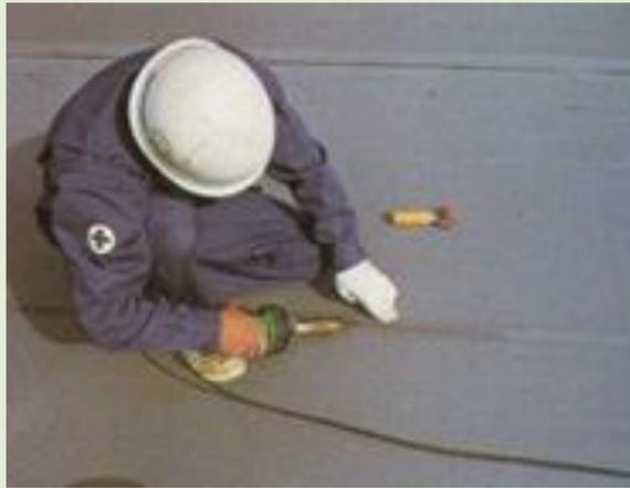
写真 8.23 塩化ビニル樹脂系シート張り・熱融着の例
