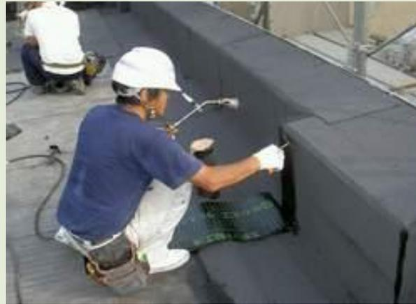
写真 8.20 改質アスファルトシートの増張りの例
