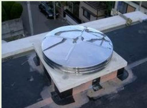
写真 8.7 マンホール部のシート防水の例
