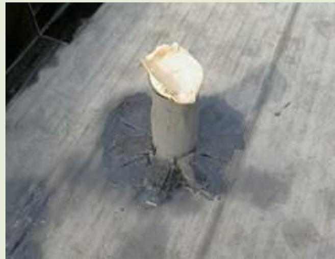
写真 8.12 貫通管部のシート防水施工例
