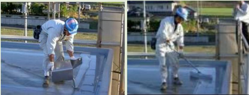
写真 8.25 塗膜防水材料の流込み、均し施工例
