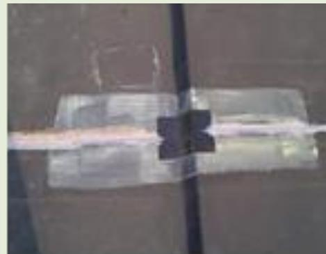
写真 8.22 加硫ゴム系シート防水の防水補強各部位の例
