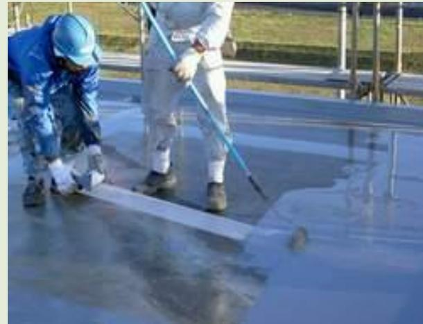
写真 8.24 補強布の張付けの例
