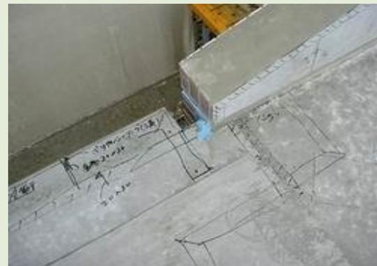
写真 8.5 シート防水の納まり詳細の検討状況の例
