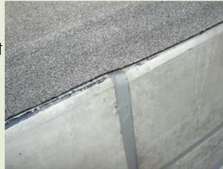
写真 8.15 プレキャスト部材目地シーリング部のシート防水施工の例
