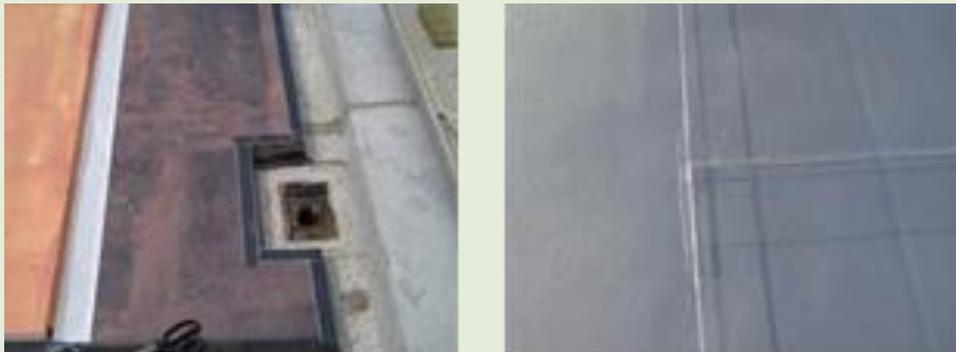
写真 8.21 プライマー塗布、接合端部の防水補強の例
