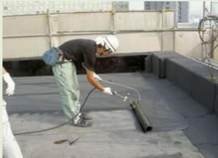
写真 8.18 改質アスファルトシートの張付けの例
