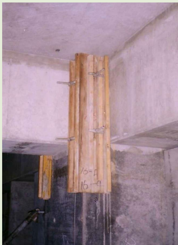
写真 7.1 柱-梁交差部型枠の例
