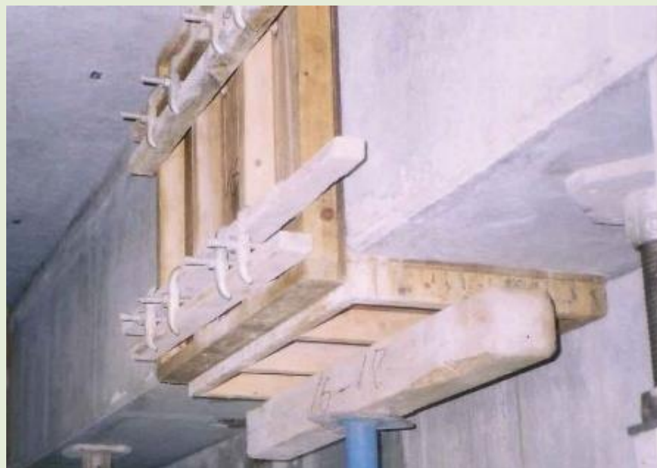
写真 7.2 梁中央接合部型枠の例
