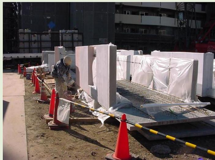
写真 5.2 部材の先行仕上げの例
