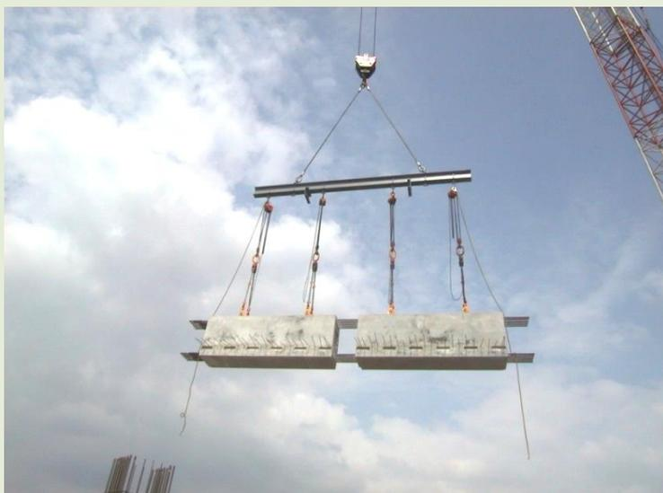
写真 5.3 吊上用鉄骨ビームの例
