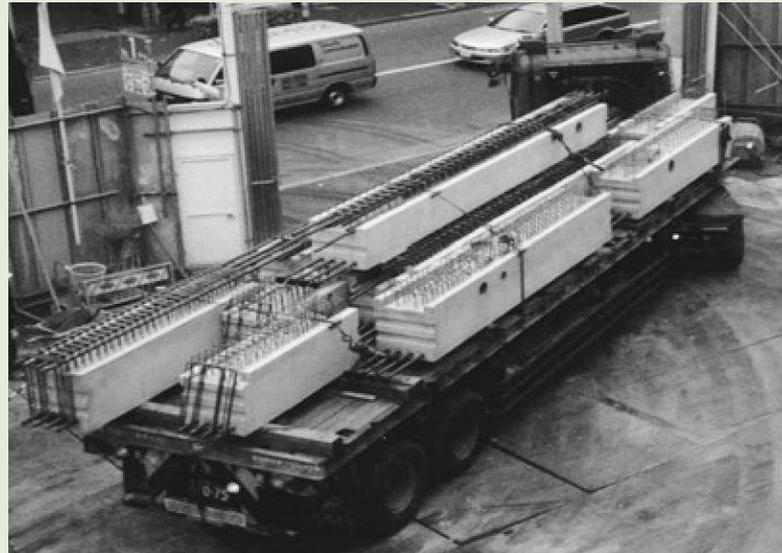
写真 4.7 梁部材平積み例
