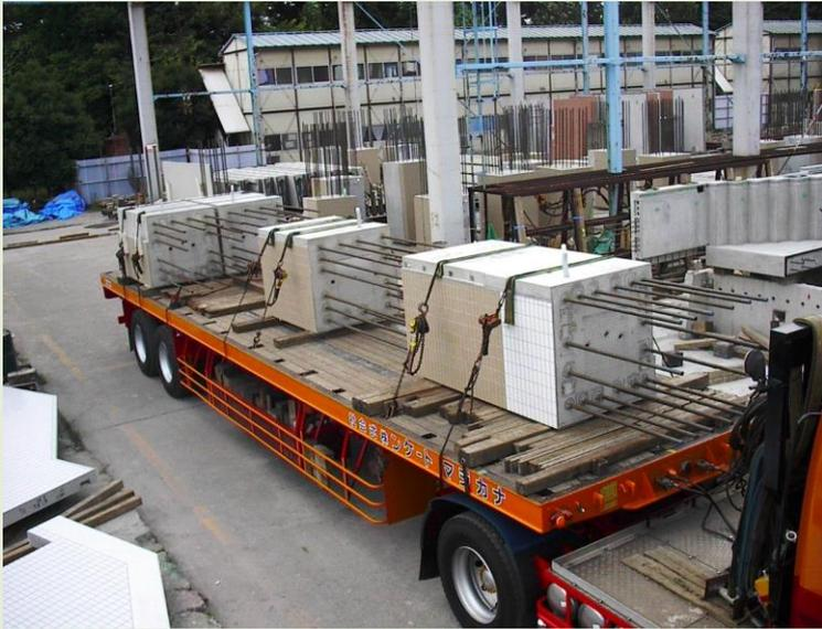
写真 4.5 柱部材平積み例
