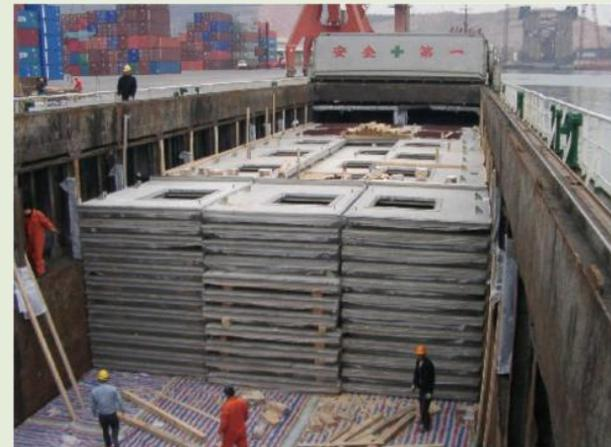
写真 部材単体で船積みの例
