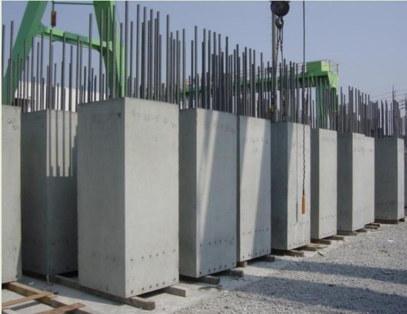
写真 4.3 柱部材の貯蔵方法の例
