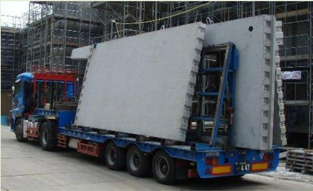
写真 4.8 壁部材縦積みの例
