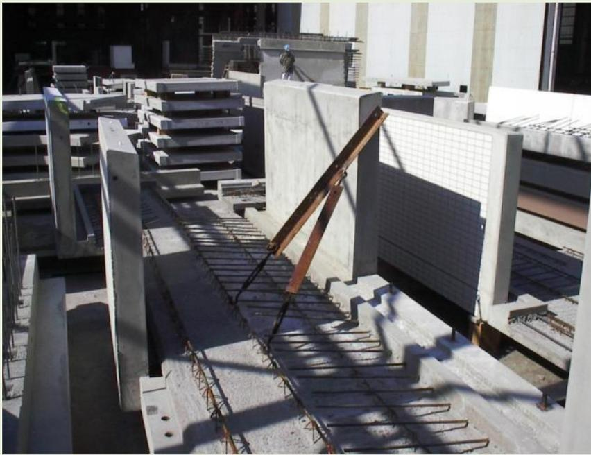
写真 4.9 片持ち床部材の変形防止の例
