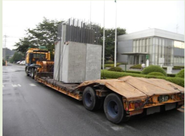
写真 4.6 柱部材縦積み例
