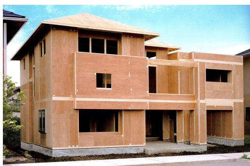
図 2.19 構造躯体 (ミサワホームの例)
