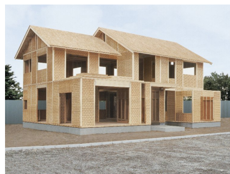
図 2.20 構造躯体 (ヤマダホームズの例)
