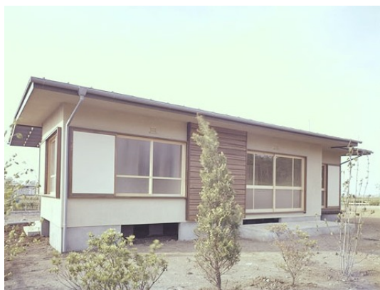
図 2.1 木質パネル接着工法試作住宅第 1 号 (1961) 1)
