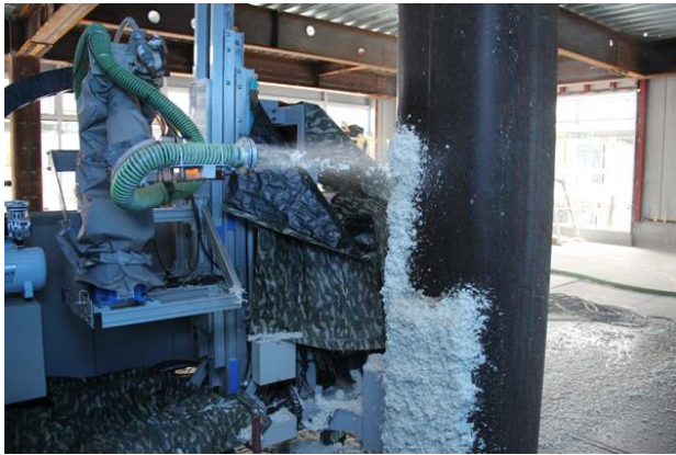
耐火被覆吹付ロボット
