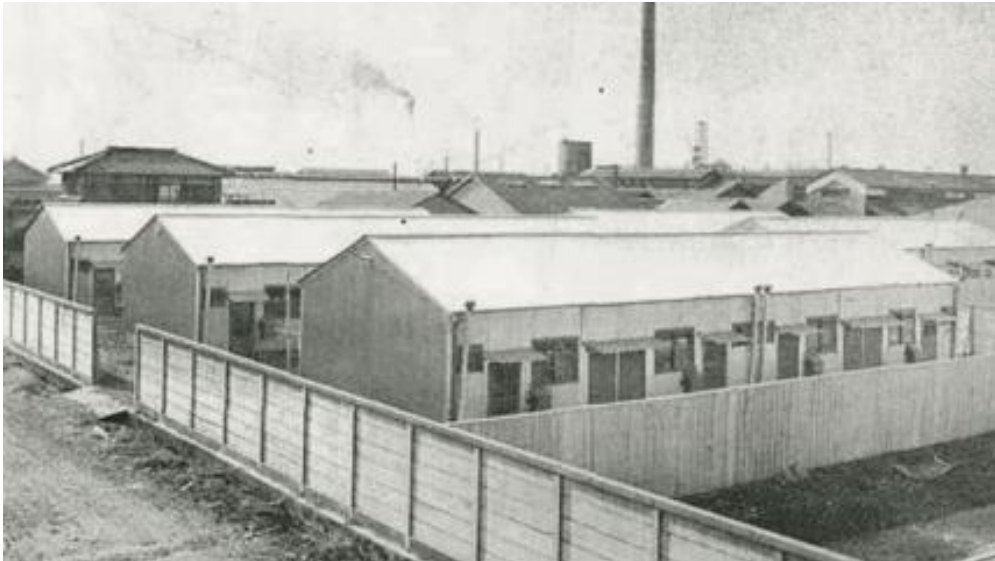
1959年 応急仮設住宅
