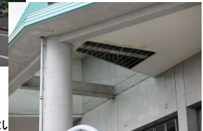
外観は大きな被害は見受けられなし 軒天が一部破損
