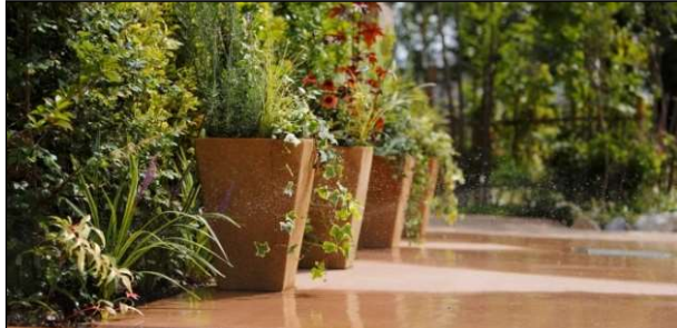
瓦骨材利用保水性舗装+散水システム
