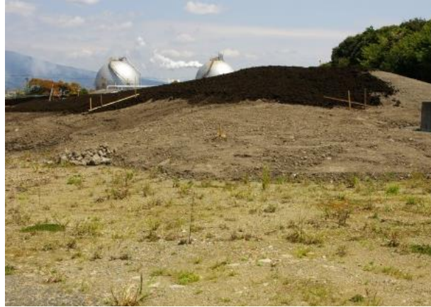
現地発生土の地盤の上に 客土が進んでいる
