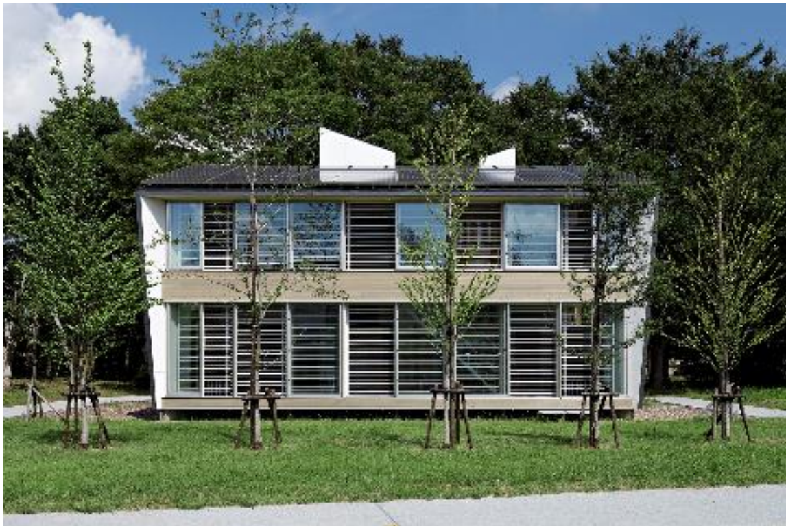
LCCM住宅デモンストレーション棟南立面
