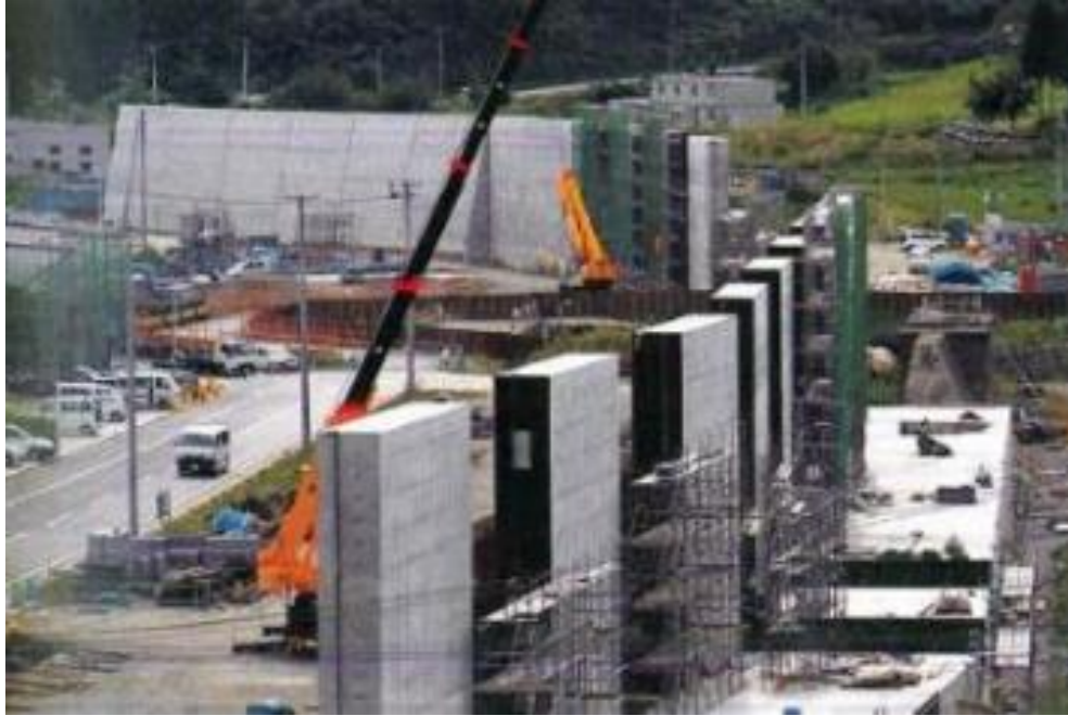
防潮堤が建設される被災地の海岸線
