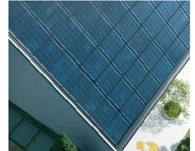
太陽光パネル
