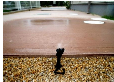
全戸：保水瓦骨材利用コンクリート +ミスト
