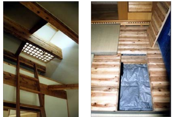
■越屋根の見上げ
