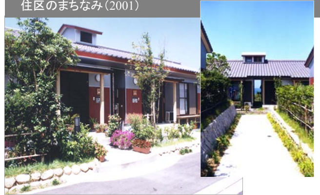
地域の既存伝統集落に学んだ住宅のつくり方、配置に基づくまちなみの形成
