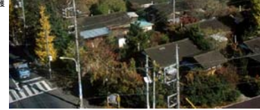
■建て替え前の都宮深沢住宅
