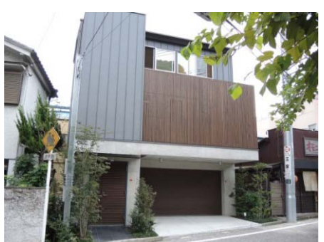
にぎわいのある通りに面して2層の格子により、通りのアクセントとなる住宅
