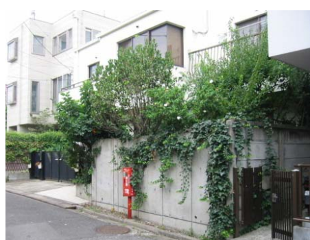
ツタ壁面緑化によるRC擁壁
