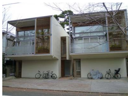
オーバーハングしたバルコニーとピロティ空間の壁面線を揃えてオープンスペースを創出
