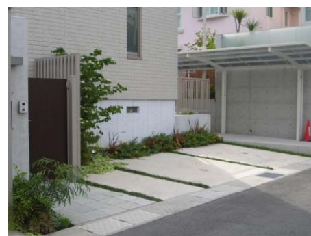
基礎際に低木を植え、タイルと緑化目地による仕上げ
