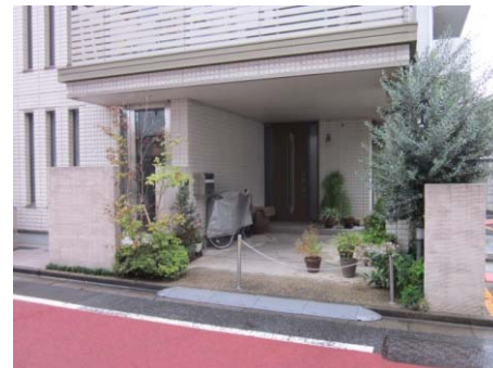
玄関アプローチと駐車場を組み合わせ、外構の塀と一体的にデザイン
