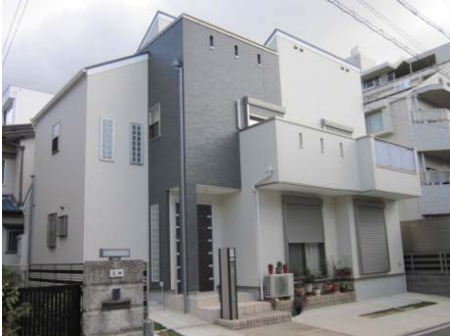
建物を雁行させることにより、壁面の単調さをなくした事例
