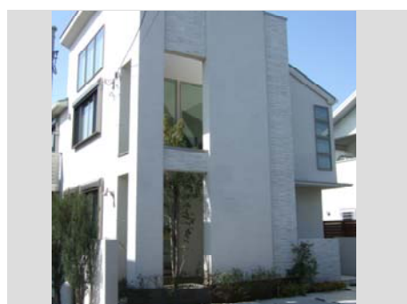
ダブルスキン式の外壁で建物の立体感をデザイン
