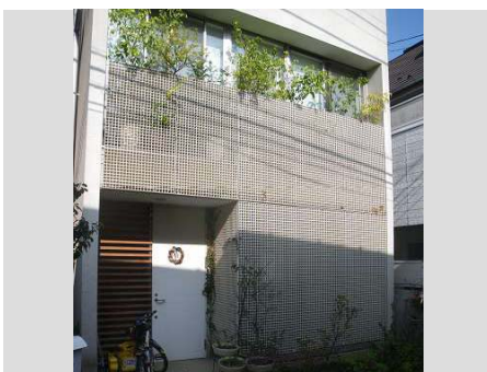
格子を全面に採用することで、面的な一体感のあるファサードとし、プライバシーを確保
