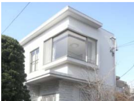
コーナー部分を柱のない開口とし、斜めに抜ける眺望を確保
