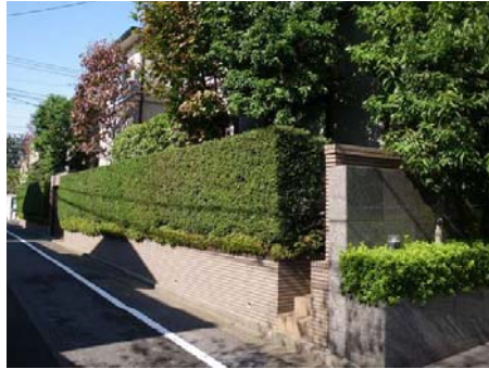
土留め上の生垣
