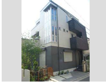
上下階で貼り分けたアクセント外壁の事例
