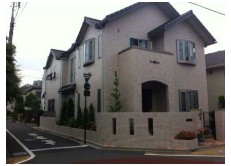
建物の外壁と同じタイルを使用した塀
