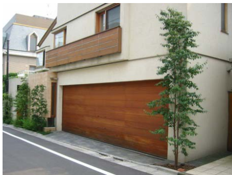
木質のガレージシャッターとフラワーボックス等の素材感や色調を合わせたデザイン
