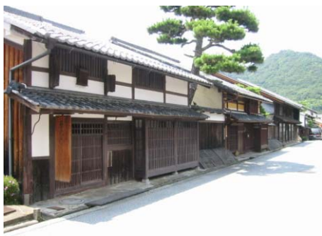
商業活動の中心をなす在郷町として発展した重要伝統的建造物群保存地区のまちなみ(滋賀県近江八幡)
