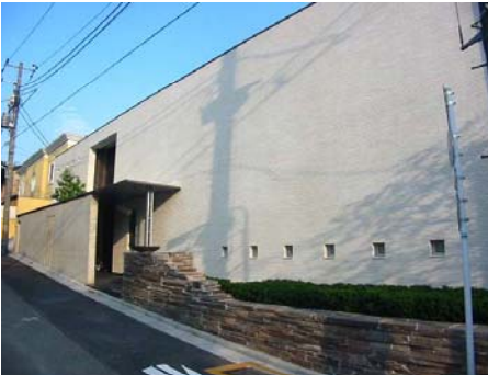
開口部を少なくし、建物と一体となった土留めと植栽帯により構成された都市型デザイン
