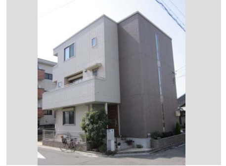
垂直面で貼り分け、縦方向のスリット開口部で壁面の重圧感を緩和させた事例
