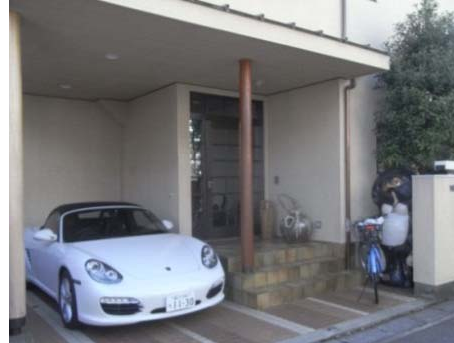
玄関庇と連続し水平ラインを強調した一体感のあるピロティデザイン
