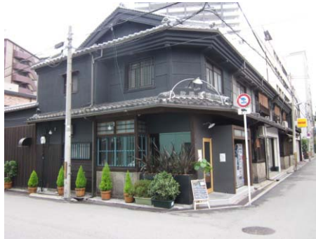
市街地に残る町屋を改修した店舗併用住宅
