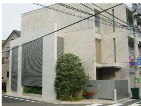
角地のコーナーに植栽スペースを設け、コンクリートと金属製ルーバーを組み合わせたデザイン
