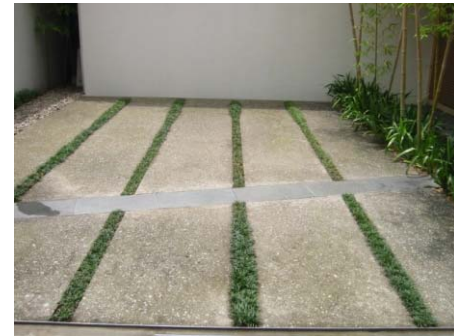
洗い出しと自然石、緑化目地の組み合わせ
