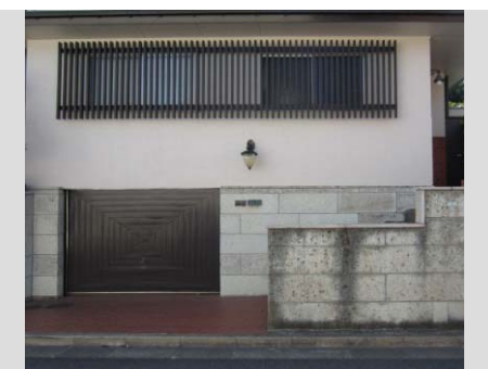
高さを揃えた幾つかの開口部を窓格子でつなげ、外観をシンプルに整理
