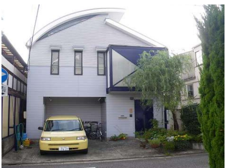
屋根や開口部の特徴のある建物外観とシンボリックの緑でアイポイント
