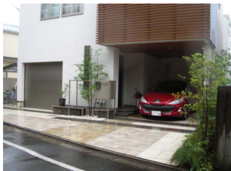
ビルトインガレージ上部をオーバーハングさせ、ファサードに立体感を与える
