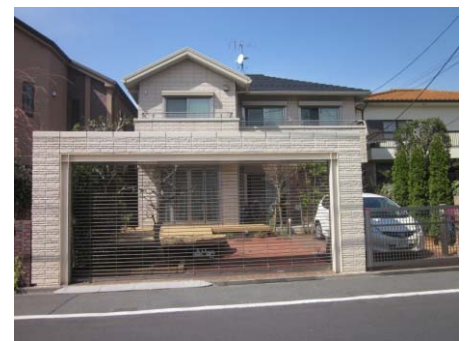
建物と素材を統一し、パイプシャッターで前庭を見せるゲート
