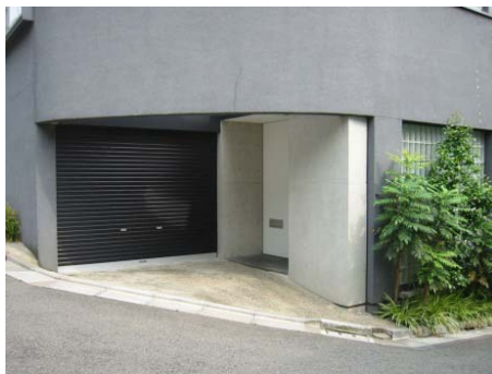
車の出入り方向の工夫で角地の有効利用をしたビルトインガレージ
