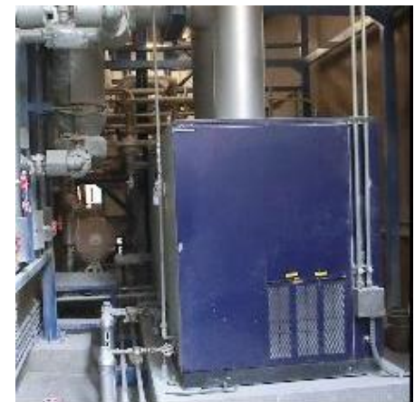
内装材メーカー様に導入 いただいた“蒸気コンプレッサ”
