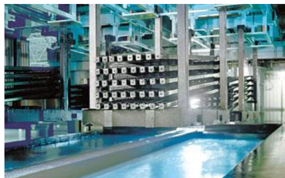
住宅：鉄骨の電着塗装
