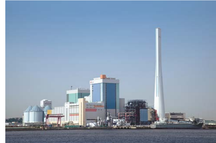
世界最高水準の熱効率を達成した磯子火力発電所(J-POWER)の概観写真
