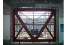
【補強】枠付き鉄骨ブレースを設置する工法の例
