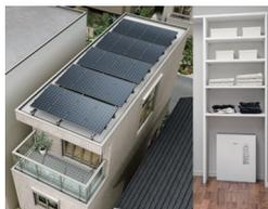
太陽光発電は、自立運転機能によって、停電時にも電力供給が可能。さらに蓄電池と組み合わせレジリエンス性を高める。環境性に加えて、太陽光の自家消費による経済性や防災面の有用性を併せて提案する。
