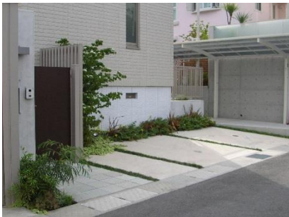
基礎際に低木を植え、タイルと緑化目地による仕上げ
