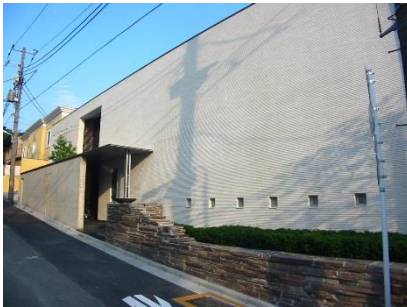
開口部を少なくし、建物と一体となった土留めと植栽帯により構成された都市型デザイン
