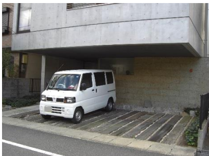
建物の間口全面をオーバーハングさせ、敷地の有効利用を図った事例
