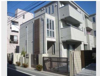
外壁等のデザインが工夫された賃貸併用住宅
