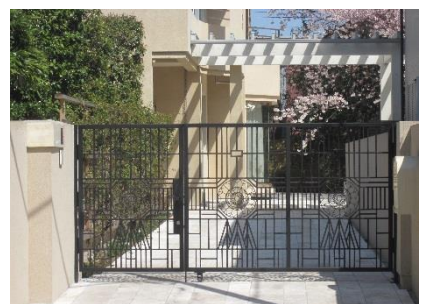
アプローチ・駐車場を閉じる意匠性のある門扉
