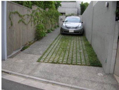
洗い出しと緑化ブロックによる旗竿敷地の駐車場兼アプローチ
