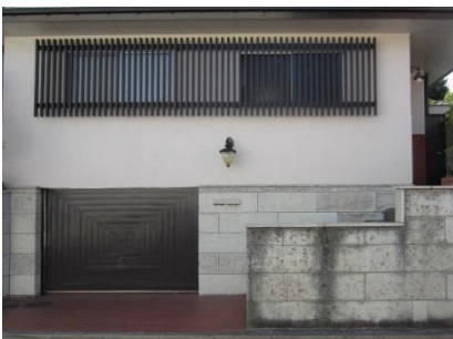
高さを揃えた幾つかの開口部を窓格子でつなげ、外観をシンプルに整理
