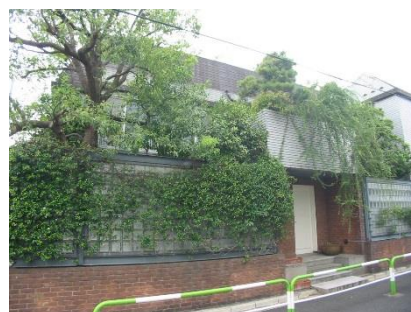
塀の緑化により緑視率を高める
