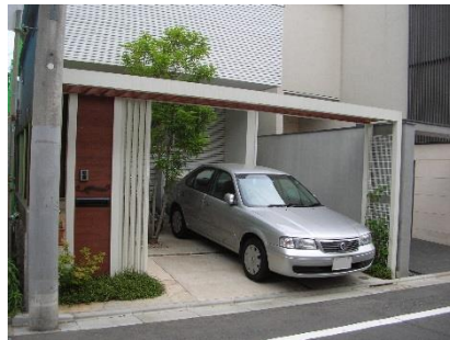
シンプルな形状で領域性を出しながら、オープンなアプローチ空間
