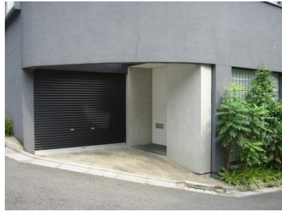
車の出入り方向の工夫で角地の有効利用をしたビルトインガレージ
