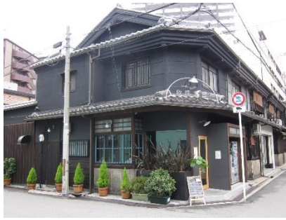
市街地に残る町屋を改修した店舗併用住宅
