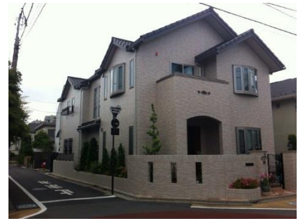
建物の外壁と同じタイルを使用した塀
