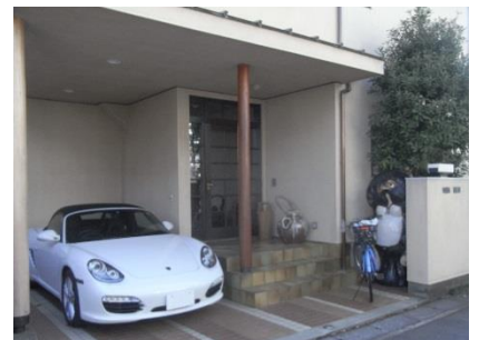
玄関庇と連続し水平ラインを強調した一体感のあるピロティデザイン
