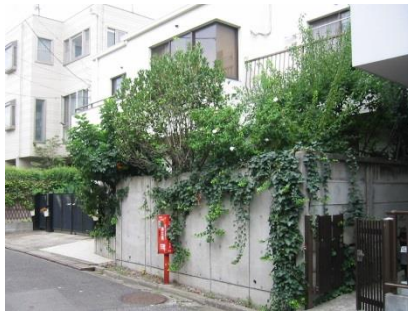
ツタ壁面緑化によるRC擁壁
