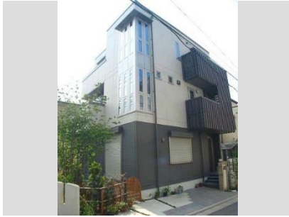
上下階で貼り分けたアクセント外壁の事例
