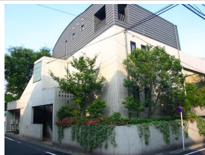
角地のシンボルツリーと下垂性の緑による擁壁の緑化
