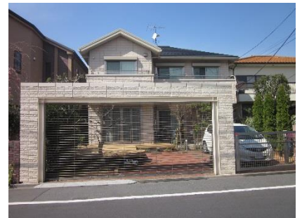
建物と素材を統一し、パイプシャッターで前庭を見せるゲート
