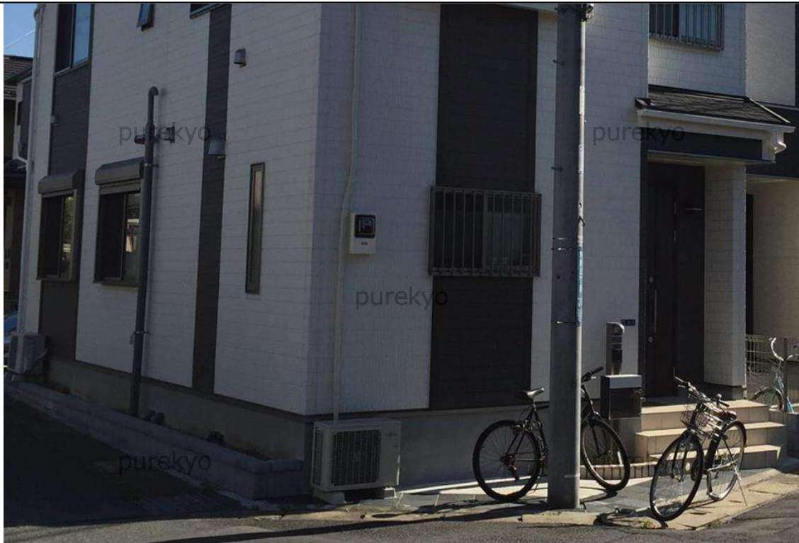
区画は小さく分割され、緑もなく、室外機が露出していることも。
