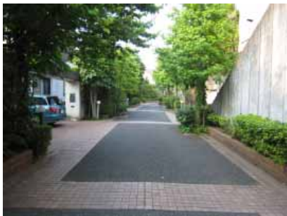
レンガで舗装
