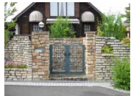
再生レンガを用いた門廻り
