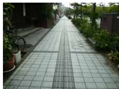
点字ブロックを設置した歩道
