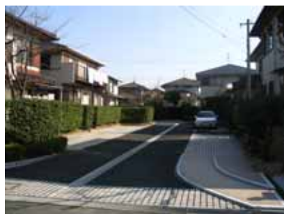
排水の工夫 センター排水溝
