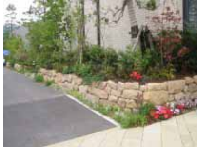
自然石による土留め
