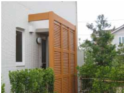
勝手口の前に目隠しを設置
