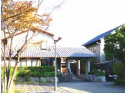
建物と一体となっているガレージ
