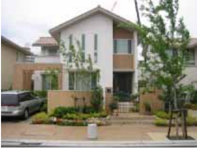
建物と同一のタイルを用いた門廻り
