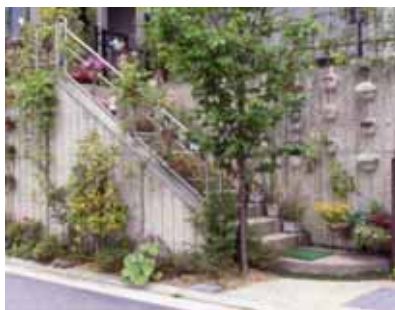
化粧型枠によりデザインされた擁壁
