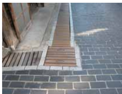
U字側溝にかけられた木製の溝蓋
