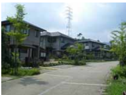
道路と宅地の段差を無くす
