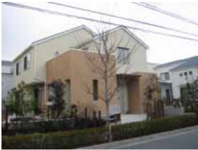
外壁にアクセントタイルを使用
