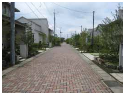
インターロッキングで舗装
