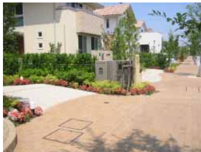
汚水、排水柵に化粧蓋を使用
