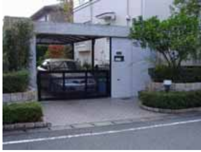
外構でゲートを設置
