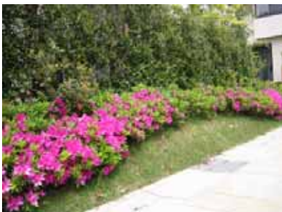
植栽による法面処理による土留め
