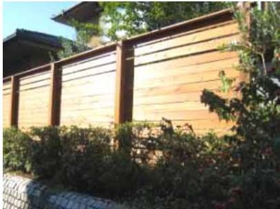
サービスヤードを木塀で隠す
