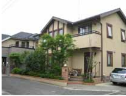
ハーフティンバーによる外壁
