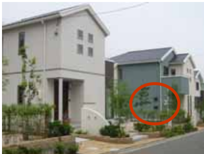
隣地に面する窓に配慮
