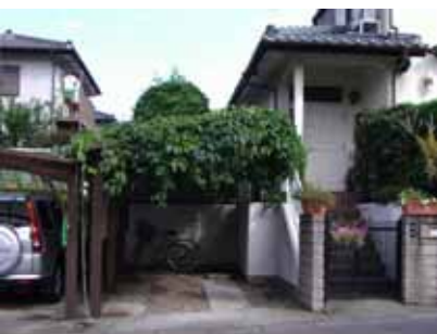
カーゲート屋根の緑化
