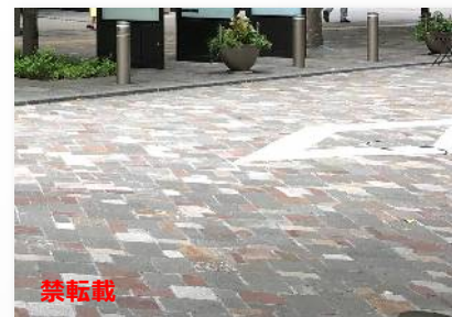
1-f.タイル舗装（例）
