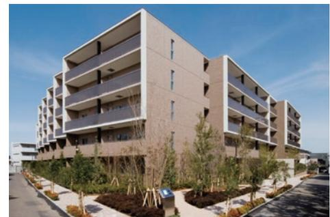
壁式プレキャスト鉄筋コンクリート工法 5階建て共同住宅の事例
