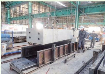
プレキャスト梁のコンクリート打設翌日の脱型状況
