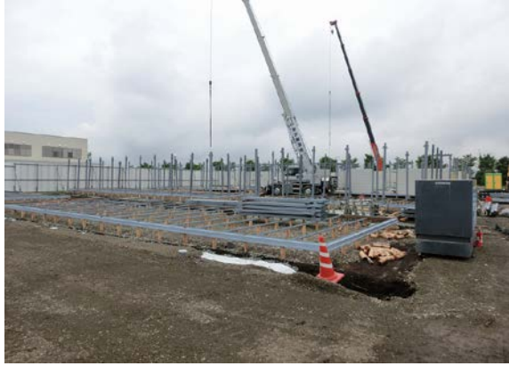
本体工事 (鉄骨)
