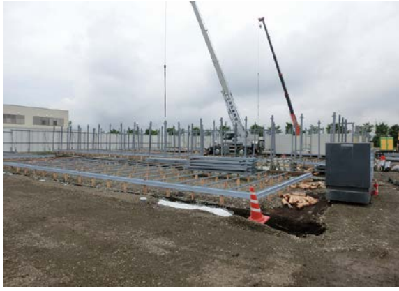
本体工事（鉄骨）
