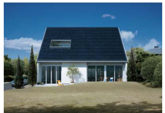
図31 太陽光発電パネル搭載住宅
