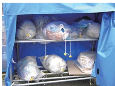
図35 施工現場廃棄物の分別保管例
